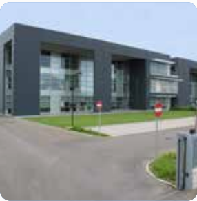
Galtech Site Cavriago (RE) • Italy
